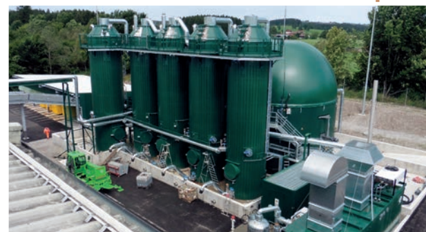
Ein wichtiger Schritt auf dem Weg zur Stromgewinnung aus dem Hausmüll: Der Bau der Presswasservergärung 2019.
