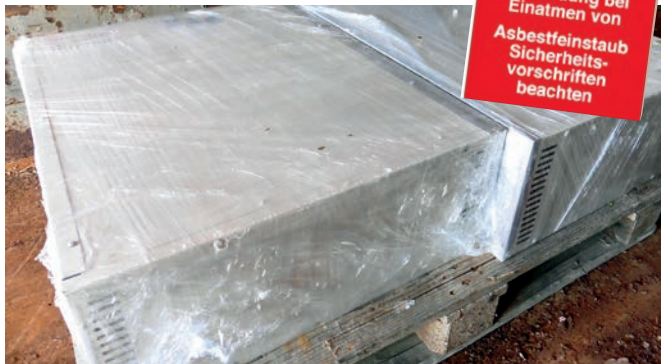
Unbeschädigt und luftdicht verpackt warten die ausgebauten Nachtspeicheröfen auf ihren Abtransport.
